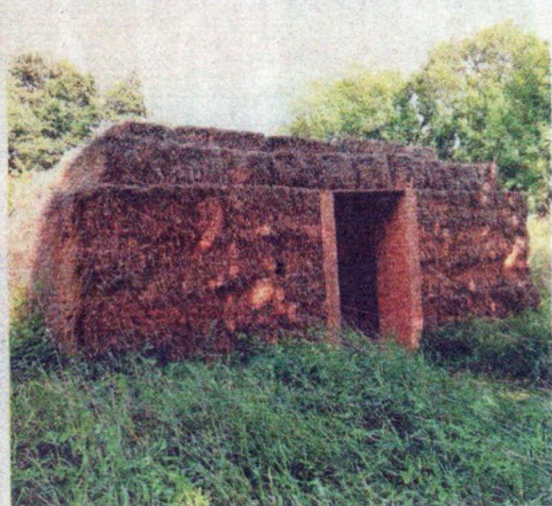
▲ Nexus is een bouwwerk van strobalen en houtplaten gemaakt door Jeroen van Westen.
